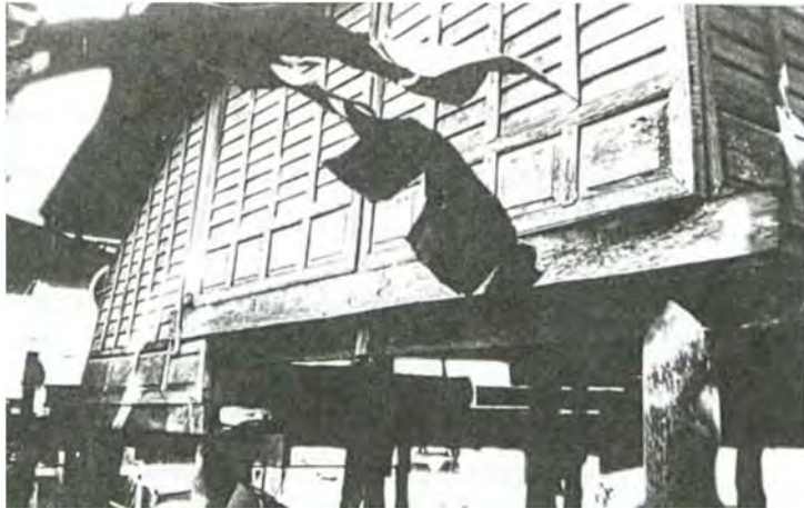
ภาพที่ ๓ ด้านข้างของเรือนนอนและพะ ที่ลดระดับลงมาเสมอพื้นระเบียง มองผ่าน ใต้ถุนเรือนจะเห็นช่องแมว ที่มา : สุวัฒน์ ตัณฑนุช, รูปแบบเรือนพักอาศัยพื้นถิ่นในภาคอีสาน (๒๕๓๑), ๗๔.
